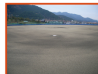
東山高等学校雁間総合グラウンド エコクレイTSリサイクル工法
