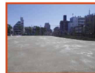
江戸川区立船場小学校運動場 エコクレイTS現場プレミックス工法
