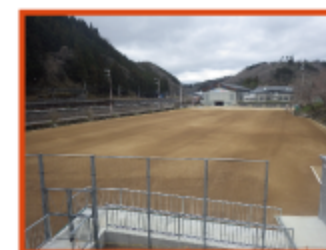
殿田中学校グラウンド エコクレイTS現場プレミックス工法
