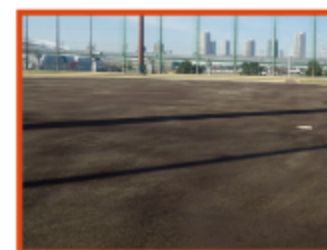
江東区夢の島野球場 エコクレイTSリサイクル工法
